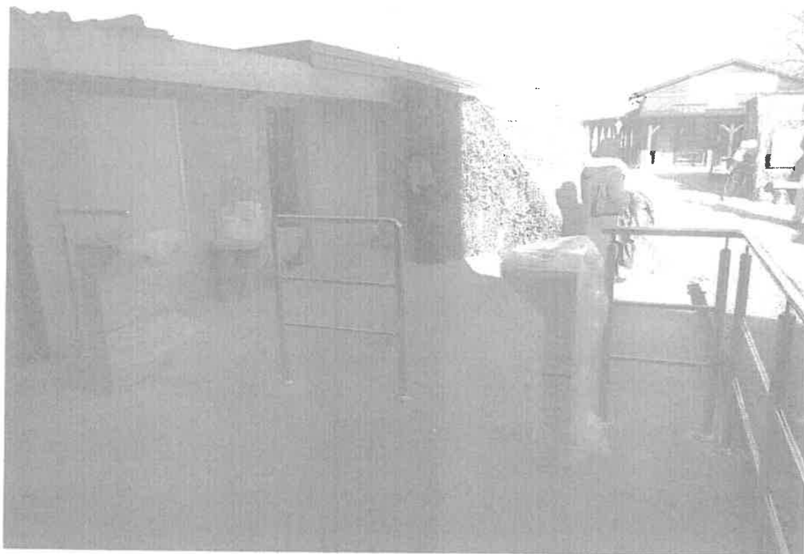
Postavljene poluvisoke barijere za kontrolu pristupa sa pripadajućom INOX ogradom ulaznog dijela Spomeničkog kompleksa Tunel D-B
