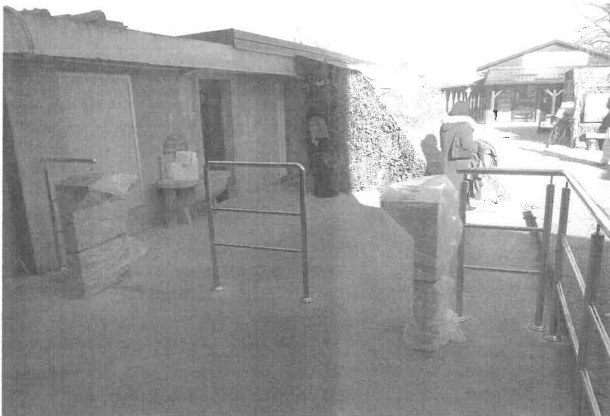
Postavljene poluvisoke barijere za kontrolu pristupa sa pripadajućom INOX ogradom ulaznog dijela Spomeničkog kompleksa Tunel D-B
