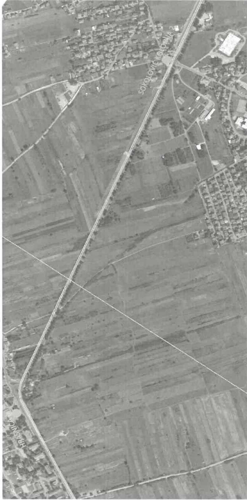
Slika 5 Treća dionica tramvajske pruge od Sokolović kolonije 2 do Hrasnice 1
